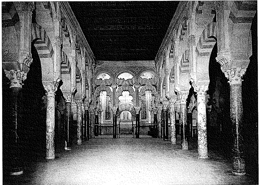
I. Abdurrahman devrinde inşa edilen Kurtuba Ulucamii'nin içinden bir görünüşü
